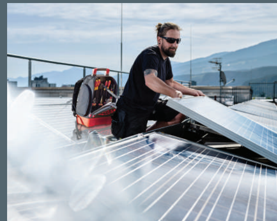
Praktikus a tetőn végzett munka során, például napelemes rendszer telepítésénél.
