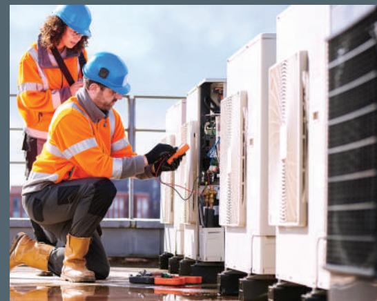
Klíma telepítése és karbantartása a tetőn.
